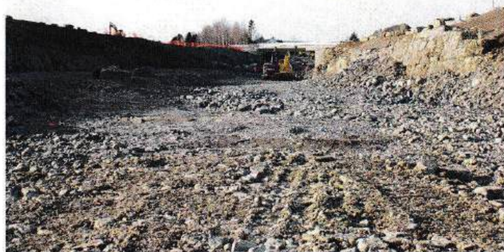
Photo prise le 15 novembre 2020. Nous sommes dans la pente du côté Est qui mène au pont et nous pouvons voir la falaise de chaque côté du tracé de la route. Nous pouvons donc réaliser l'ampleur de l'excavation.
