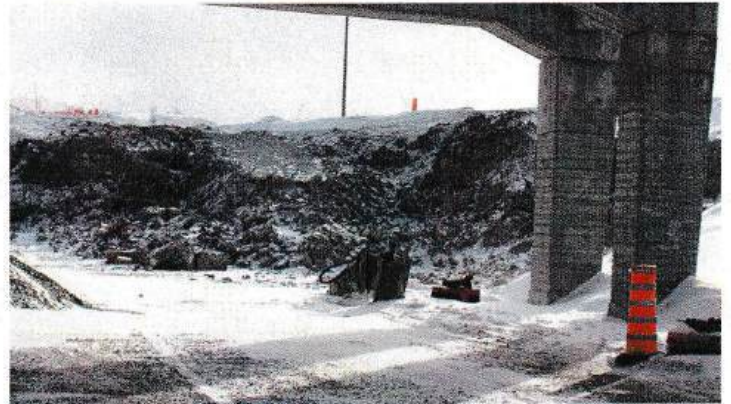
Photo prise le 30 novembre 2019. Les travaux sont terminés pour l'année 2019. Le pont est construit et fonctionnel. Et nous pouvons voir le mur de pierre à excaver pour construire la nouvelle route.
