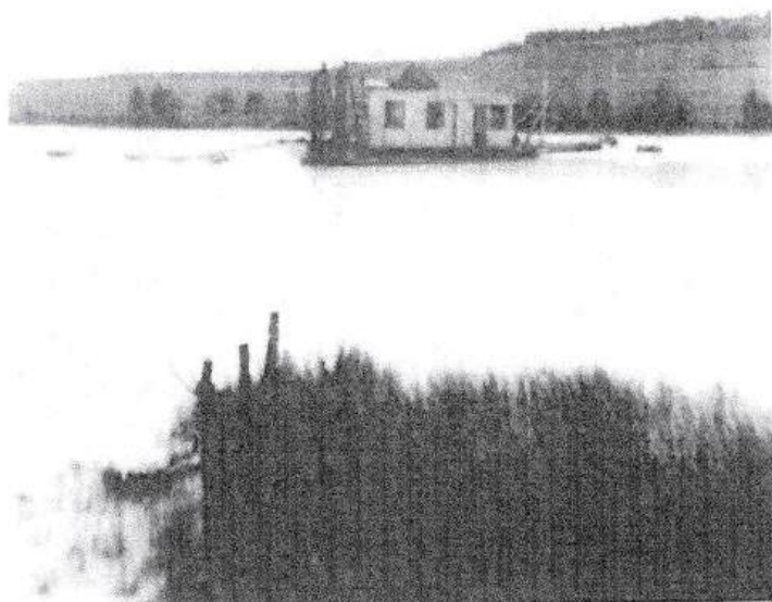
Radeau servant au pompage de la marne « Lac à Jos-Pit » 1961
