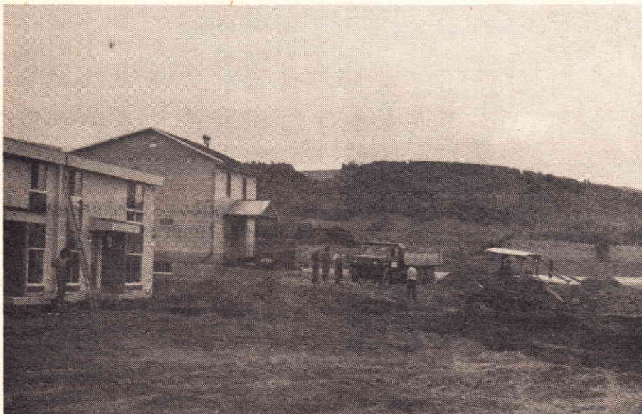
Construction du chemin au moyen d'un b lier m canique conduit par M. L onard Turgeon, Val-Brillant.
