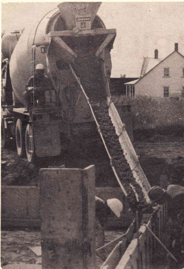
Les 9 & 13 juillet: coulage du ciment des 2 blocs appartement.
