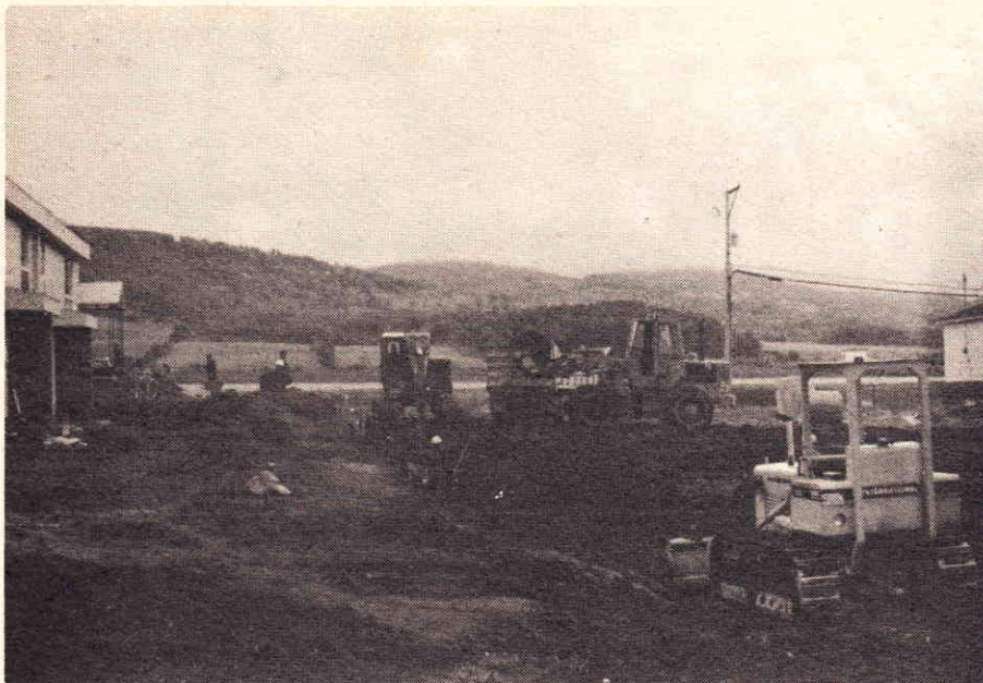
Pendant ce temps, les infrastructures d'aqueduc et d'égouts sont installées. La M.R.C. a fourni son assistance technique.
