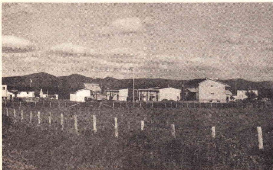
Une vue d'ensemble des nouveaux am nagements.
